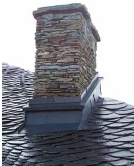
▲ Fot. 4. Obróbki komina z blachy aluminiowej
