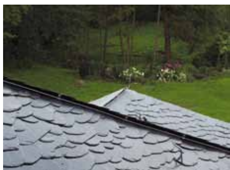
▲ Fot. 6. System odgromowy także wykonano z trwałych materiałów – stali nierdzewnej i aluminium
